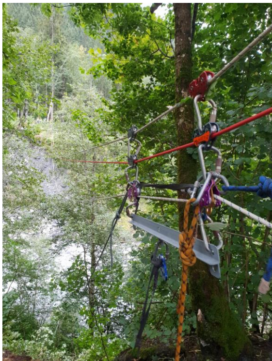
Foto; Seilbahnkonstruktion über Bach, RS Elm
